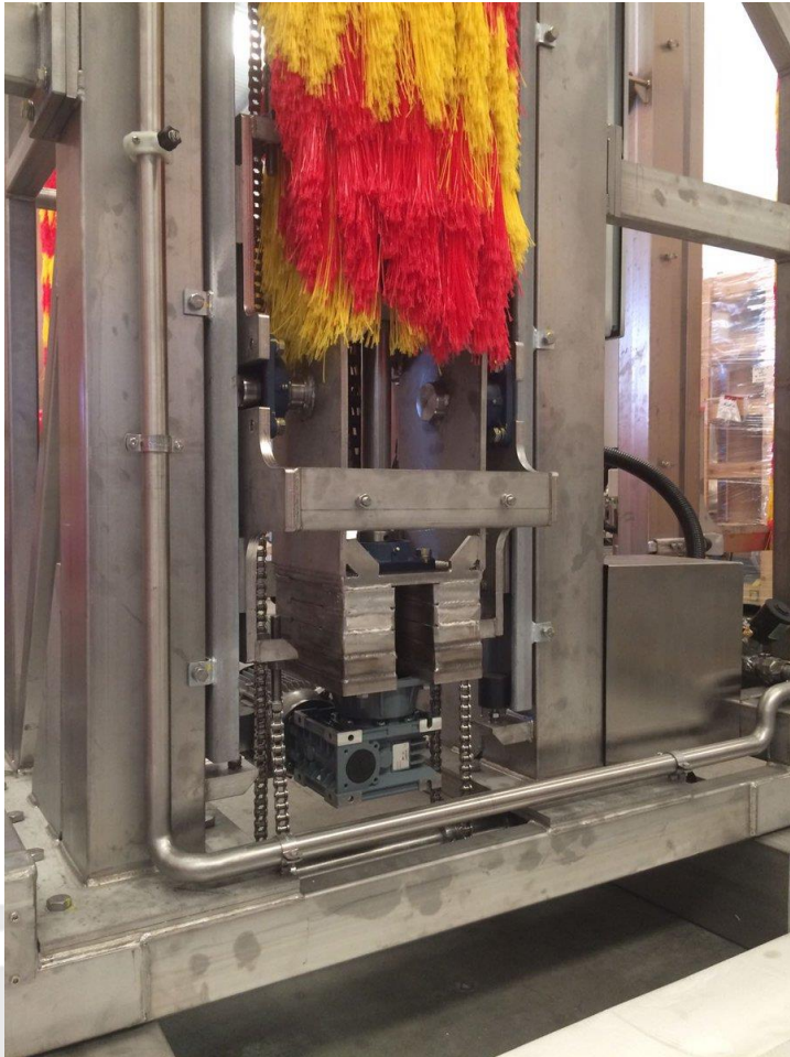
Túnel de lavado de trenes
