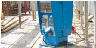
La ventanilla frontal permite a los operadores de la obra acceder fácilmente a las protecciones del cuadro en todo momento y en todo tipo de instalación.
